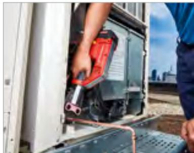
Sans flamme: l'installation sans soudure flamme évite la nécessité d'un permis de travail à chaud et évite les risques d'incendie sur le site.
