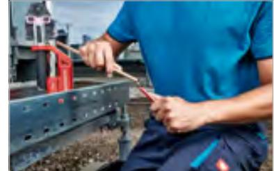
4. Nettoyez l'extrémité du tube avec un mouvement circulaire en évitant les rainures parallèles au tube
