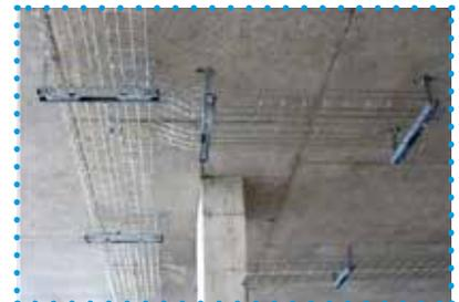
Disponible en longueur de support horizontal de 250 mm à 1 500 mm et en support vertical en 285, 535, 785 et 1 035 mm.
