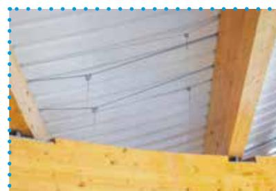
Les kits CTI sont prêts à l'emploi et comprennent : un câble en acier galvanisé coupé à la longueur désirée, deux galets et une clé de démontage.
