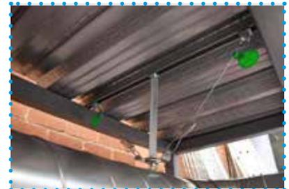
Les kits d'haubanage parasismiques prêts à l'emploi sont composés d'une longueur de câble avec embout serti et étiquette de couleur, un galet autobloquant et un étrier Standard ou Rétrofit.
