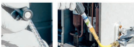
Injection du colorant en tournant la poignée.
