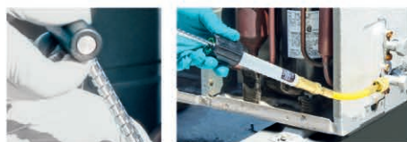
Injection du colorant en tournant la poignée.
