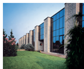
USINE DE PAVIE : IT COOLING
